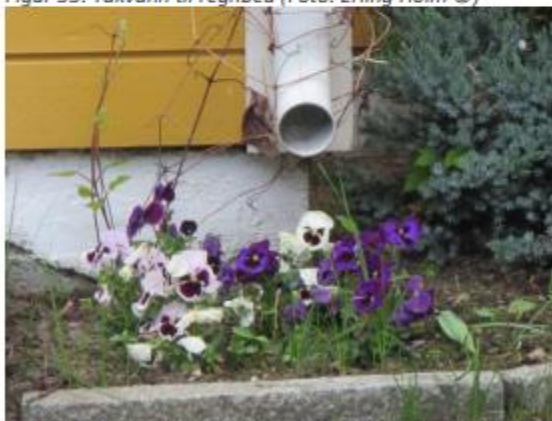
Figur 35: Takvann føres til terreng og gjør nytte for seg (Foto: Erling Holm ©)
