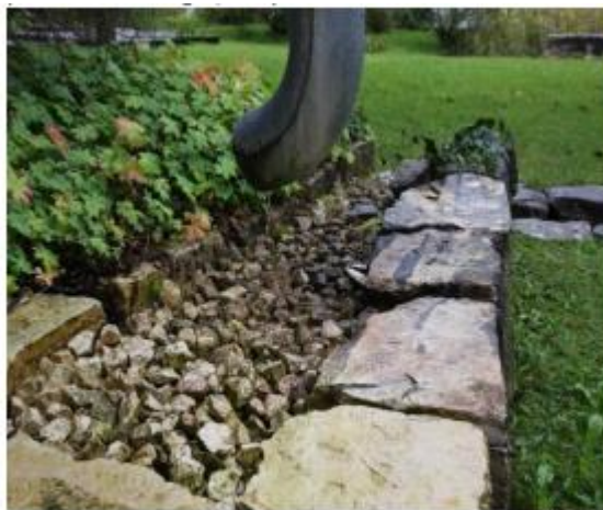
Figur 39: Takvann føres på terreng (Foto: Erling Holm ©)
