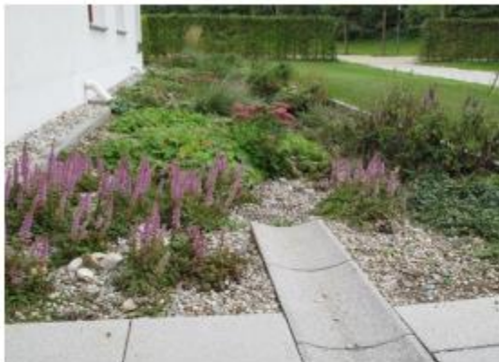
Figur 33: Takvann til regnbed (Foto: Erling Holm ©)
