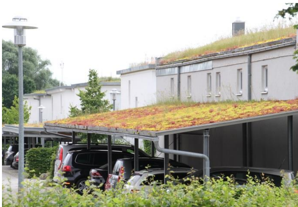
Figur 29: Eksempel på grønne tak på et rekkehus og carport (Foto: Erling Holm ©)
