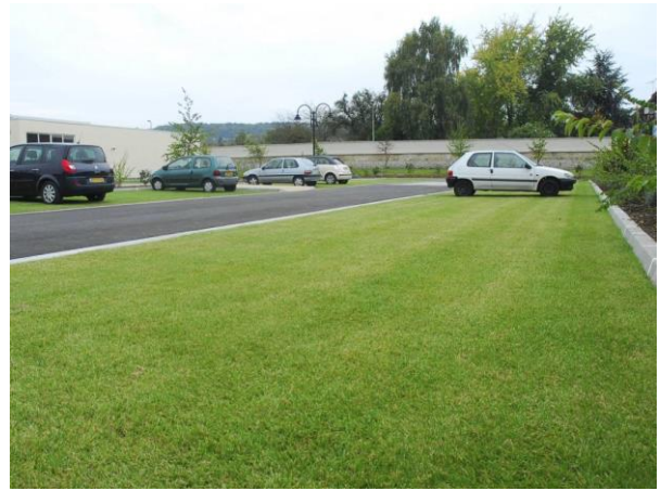
Figur 52: Parkeringsplass med gressarmering i plast (Foto: Leverandøren)
