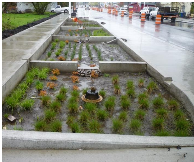
Figur 68: Infiltrasjonsbed (regnbed) i Portland, USA, skiller gangvei og sykkelstige. (Foto: Iren Piamonte Kristensen, Statens vegvesen)
