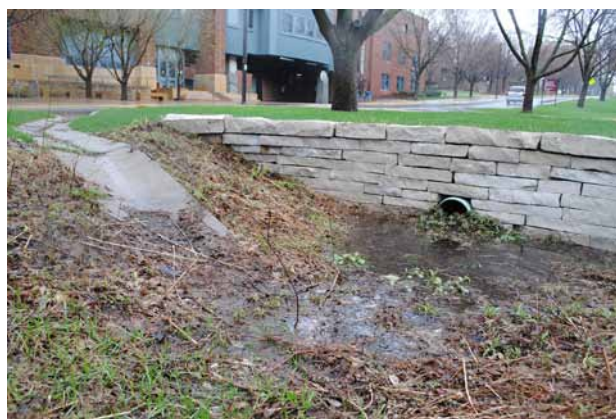
Ansamling av blader og sedimenter (slam) ved innløp til regnbed.
