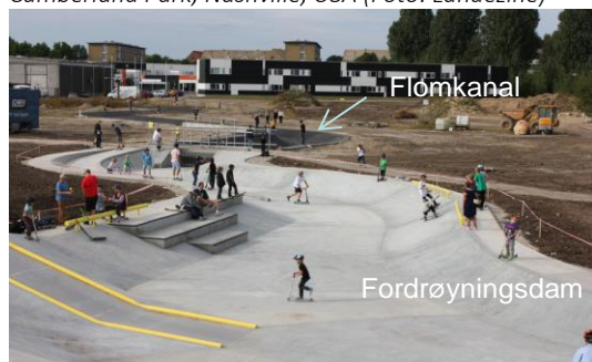
Figur 87: Roskilde Skate Park anlagt som flerbruksanlegg og flomkanal/fordrøyningsbasseng (Foto: Søren N. Enevoldsen/Sne Architects og Rune Johansen)
