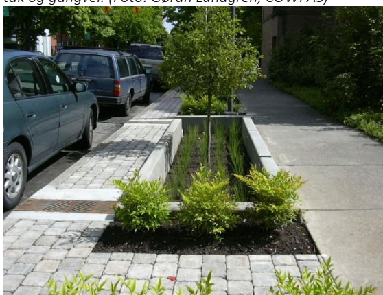
Figur 63: Infiltrasjon av veivann i Portland, USA. (Foto: Iren Piamonte Kristensen, Statens vegvesen)
