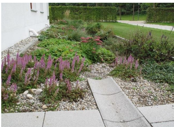
Figur 33: Takvann til regnbed (Foto: Erling Holm ©)
