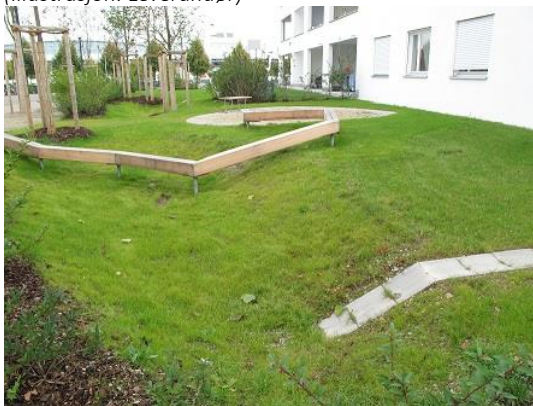
Figur 21: Nedsenket terreng kan fordrye regnvannet fra grøntareal (Foto: Erling Holm ©)
