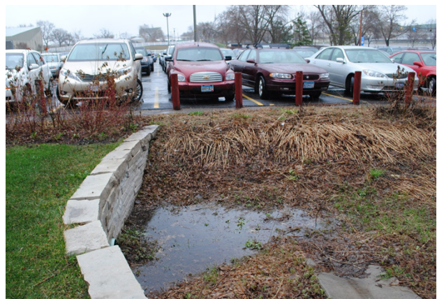
Regnbed som fanger opp avrenning fra parkeringsplass ved University of Minnesota, St.Paul, USA. Vannet infiltrerer ned til grunnen mens forurensningen forblir i filtermediet.
