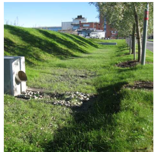
Langstrakt filterbasseng for gatevann plassert i et parkområde i by (Fornebu). Innløpet sees i forgrunnen. Anlegget har ikke forsedimenteringsenhet utover sandfang i gata.
