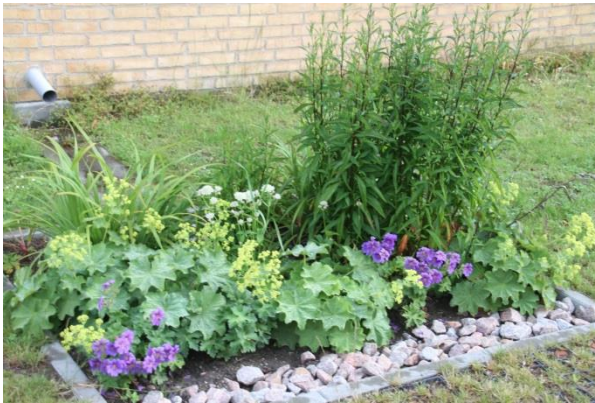
Figur 13: Takvannet avledes til regnbed (Foto: Erling Holm ©)
