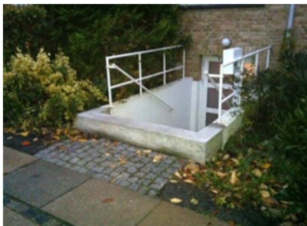
Hevede kanter rundt kjellernedganger. Foto: Rørcenteranvisning 020
