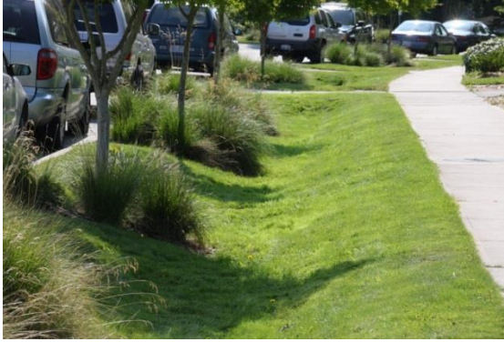
Figur 26: Fordrøyning og infiltrasjon i gressklede grøfter langs gater, kalt vadi (Foto: Erling Holm ©)
