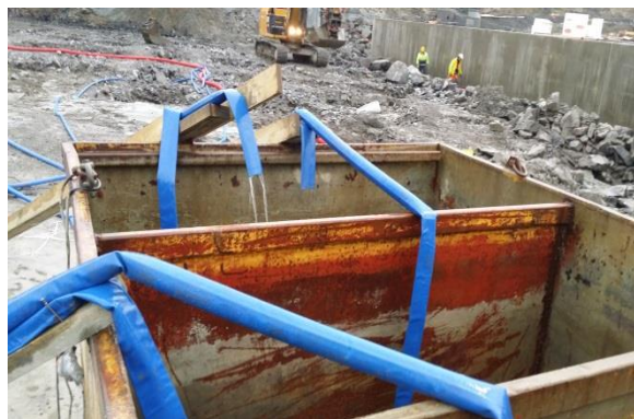
Figur 70: Sedimenteringstanker for forurenset overvann, Lørenskog Stasjonsby, Lørenskog (Foto: Yvona Holbein)
