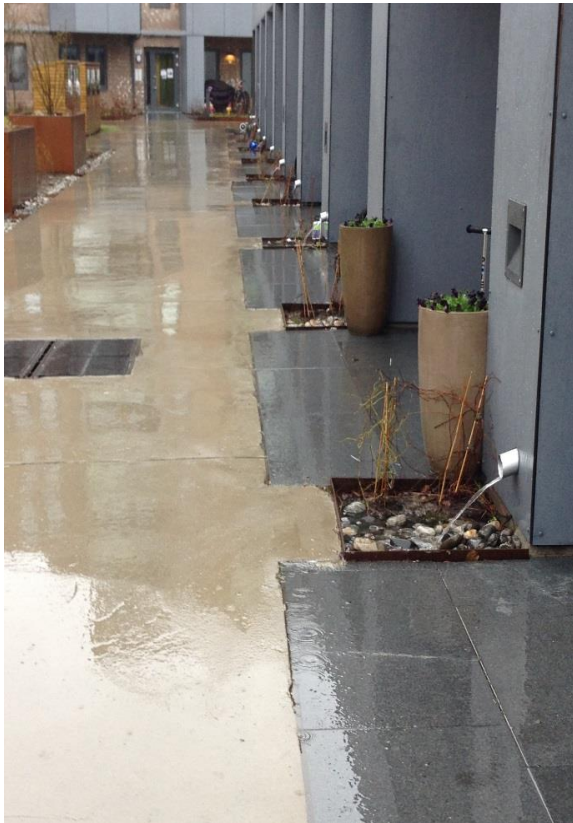
Figur 37: Infiltrasjon av takvann i Oslo (Foto: Tharan Fergus, VAV)
