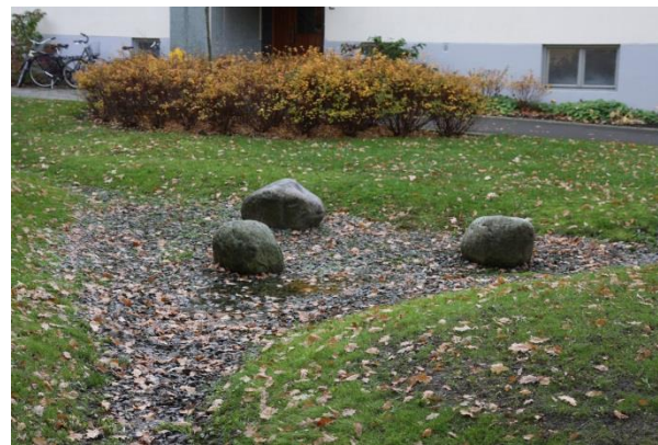
Figur 22: Nedsenkning i terrenget kan fordrye regnvannet fra grøntareal (Foto: Erling Holm ©)
