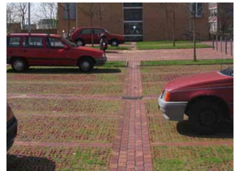
Permeabelt grasarmert dekke på p-plass.
