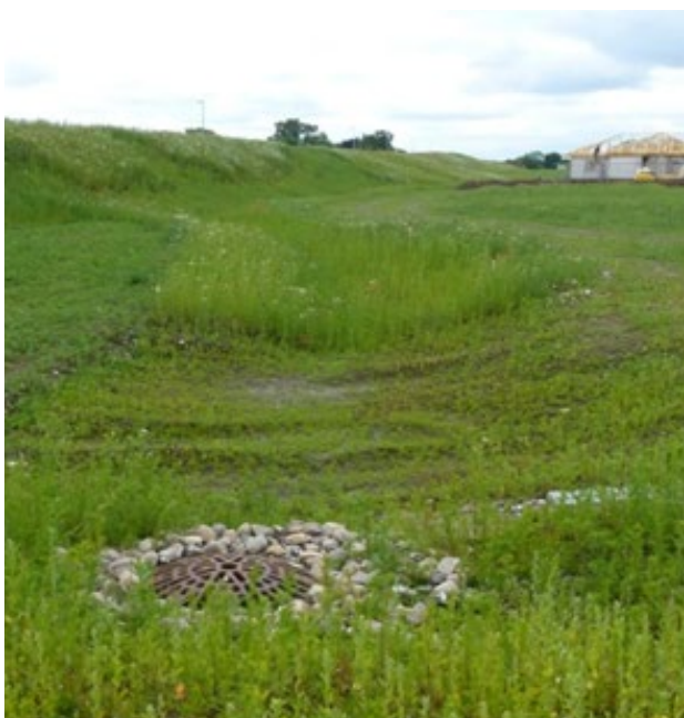
Nyanlagt vadi i forbindelse med veiprosjekt i Odense på leirjord. Ved ekstremregn ledes vannet via kuppelristen til drenerøret i bunnen av vadien. Foto: Orbicon.
