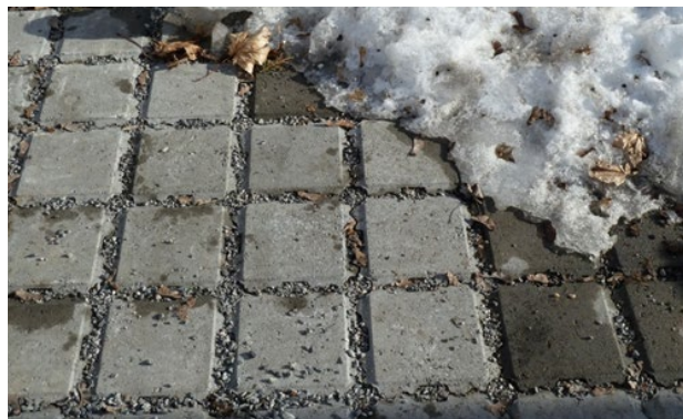
Bilde viser optøring med frost etter regnskur. Foto: Jan Eldegard
