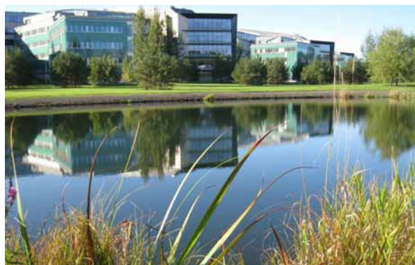
Vått basseng for takvann fra næringbygg (kontorer) med meget god vannkvalitet (Fornebu).
