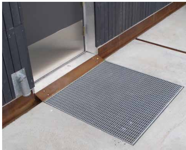
Figur 3. Vann fra tak og gangarealer. Horisontale renner gir god tilpassing til bygningene. Foto: Eivind Saxhaug
