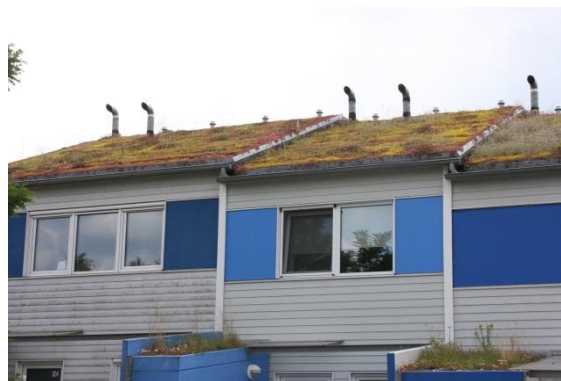
Figur 32: Eksempel på grønne tak på et rekkehus (Foto: Erling Holm ©)
