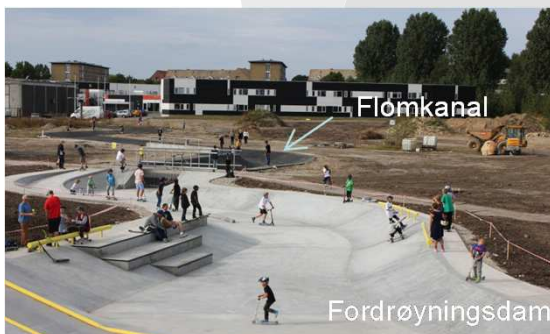
Åpent fordrøyningsbasseng i terrengforsenkning tilrettelagt for flerbruk (sportsaktiviteter) (høyre) (Washington).
