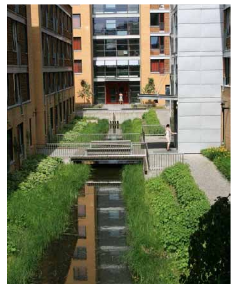
Vått basseng i gårdsrom for fordrøyning av takvann, Bjølsen Oslo (foto: Rainer Stange)
