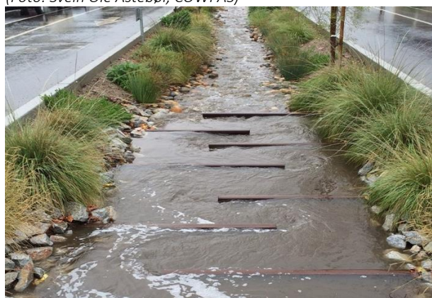
Figur 64: Åpen overvannshåndtering av veivann, Paso Robles, Seattle (Foto: SVR Design Company, Seattle)
