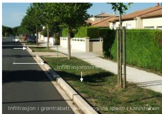
Figur 62: Infiltrasjon av veivann i grøntrabatt. (Foto: Svein Ole Åstebøl, COWI AS)
