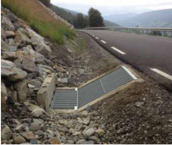
Figur 80: Selvrensende stikkrenneinntak (Foto: NVE)
